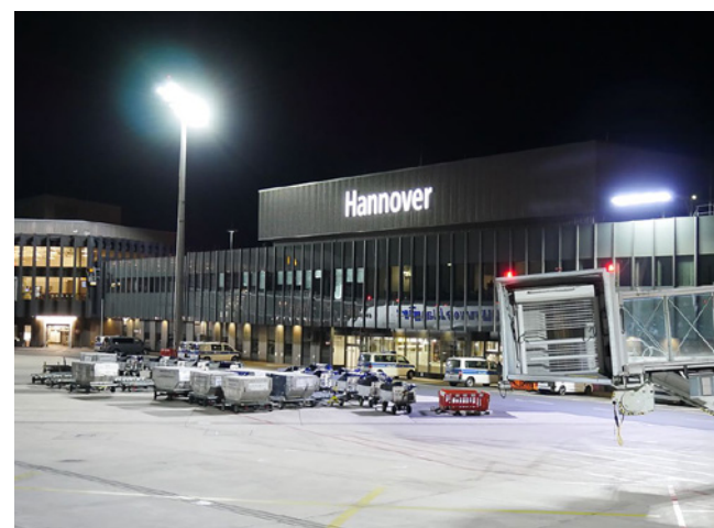
Bedarfsgerecht gesteuerte LED-Beleuchtung auf dem Vorfeld am Hannover Airport – angepasst an den Flugplan
