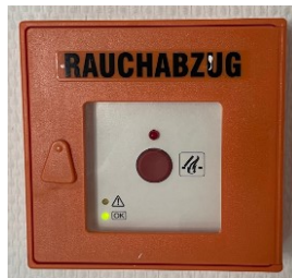
Abbildung 11: Handmelder für Rauch- und Wärmeabzugsanlagen
